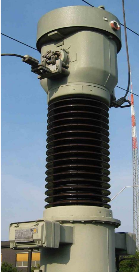
Високонапонски струјни мерни трансформатор за напоне до 110 kV
